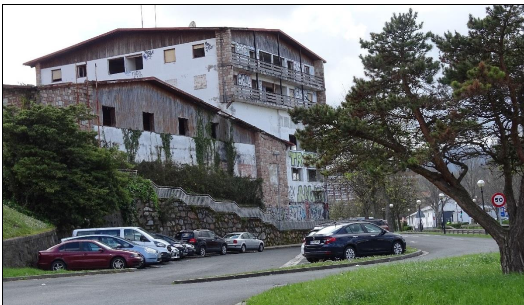
Foto 19. Antiguas instalaciones de Guascor.
