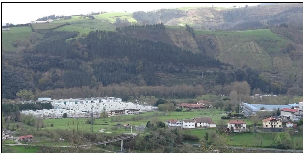
Foto 11. Pabellones industriales en Oikia
