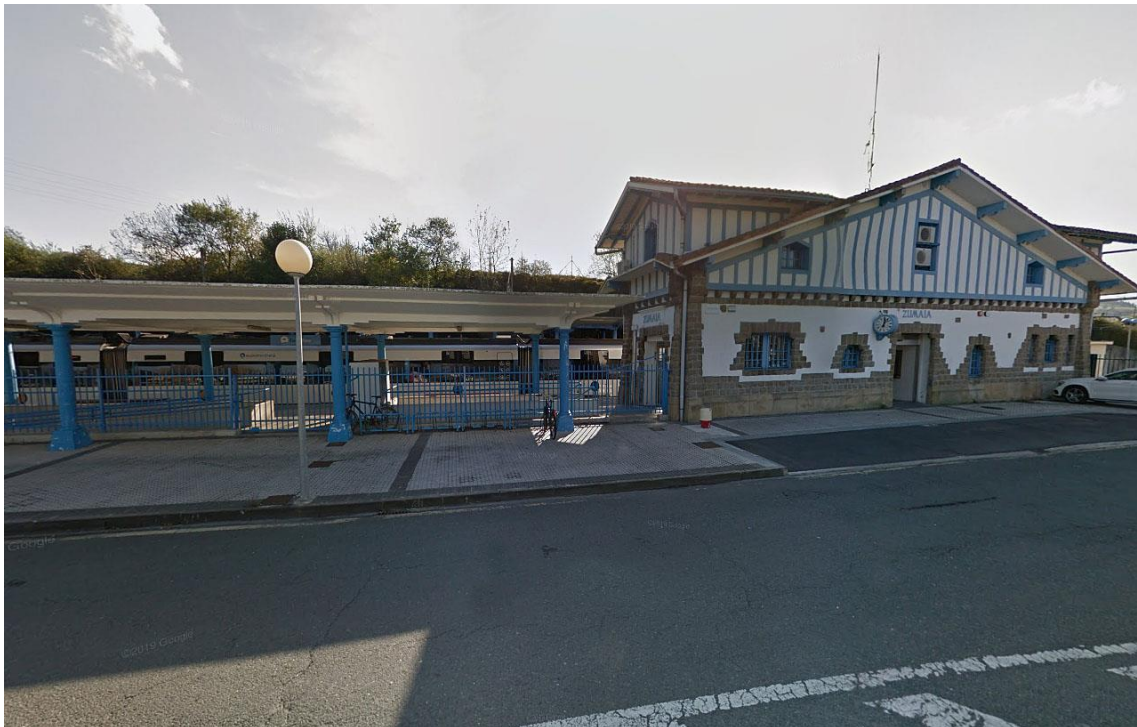
Fotografía. 14. Vista de la estación de ferrocarril de Zumaia.
