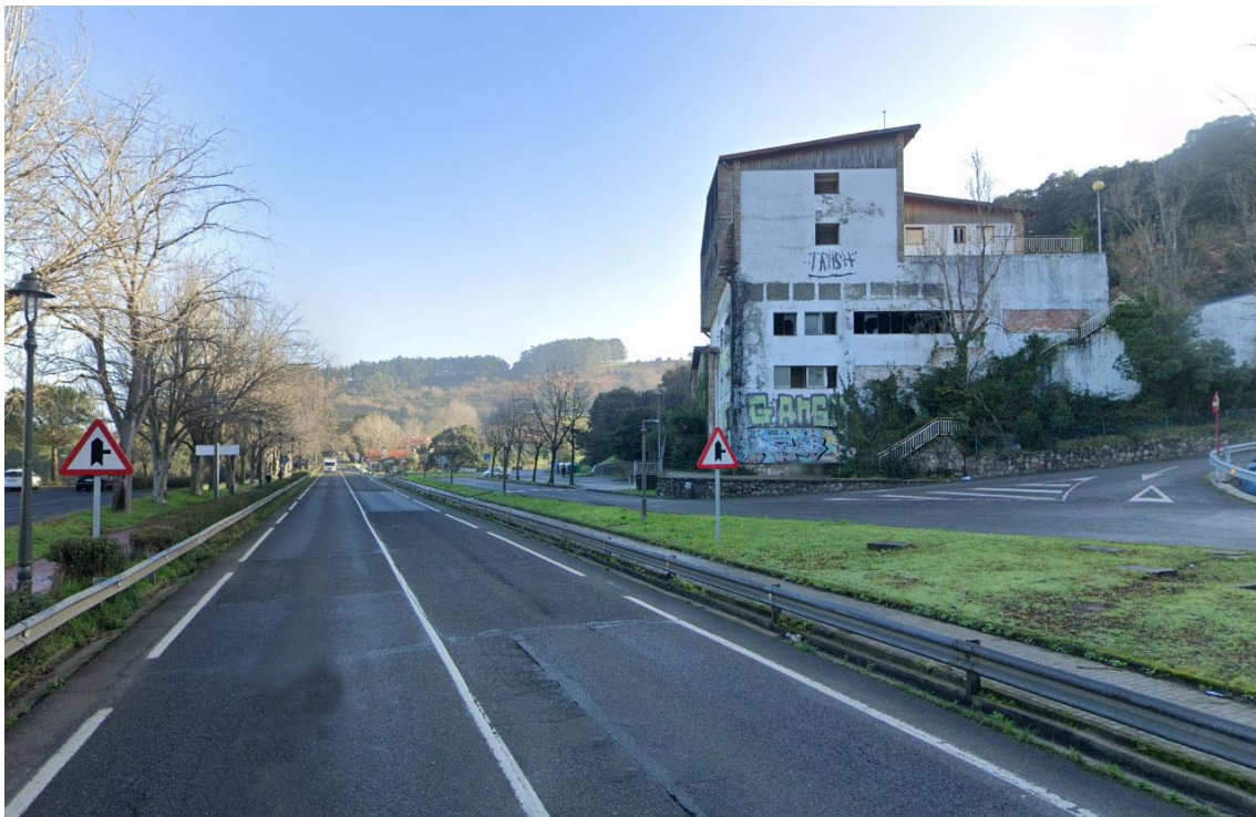
Fotografía. 3. Carretera N-634 - Santiago Auzoa. Fuente Google maps.
