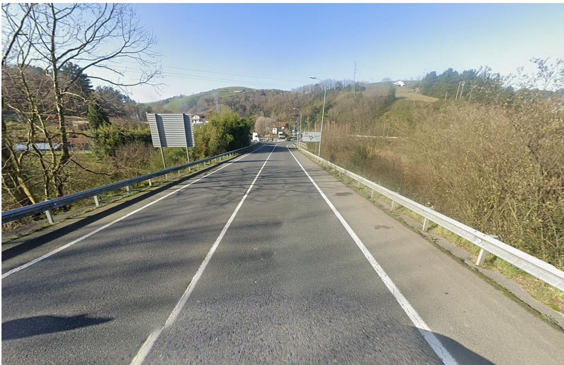
Fotografía. 10. Carretera GI-3760 - Txikierdi. Fuente Google maps.
